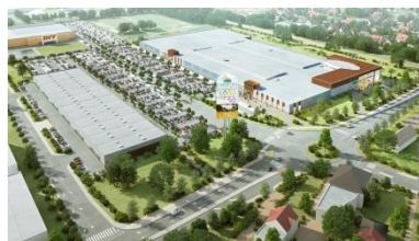
Fabryka Wołomin 31 000 mkw. GLA Park Handlowy Wołomin
